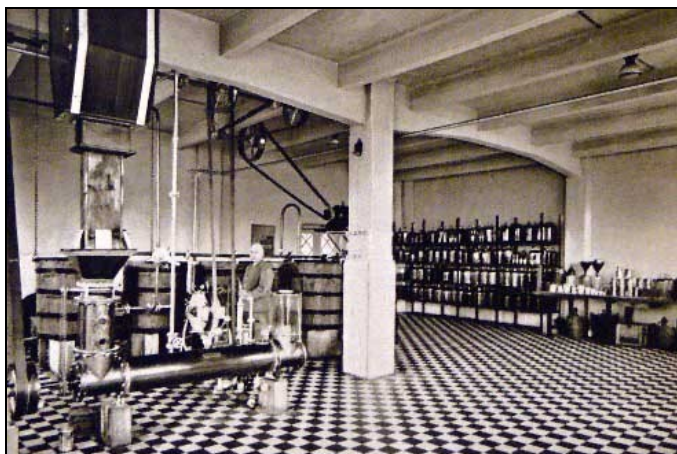
Parní varna ovocných šťáv zařízená tak, aby celá výroba proběhla bez doteku lidské ruky. Skladiště sodovek a limonád určených k prodeji.
